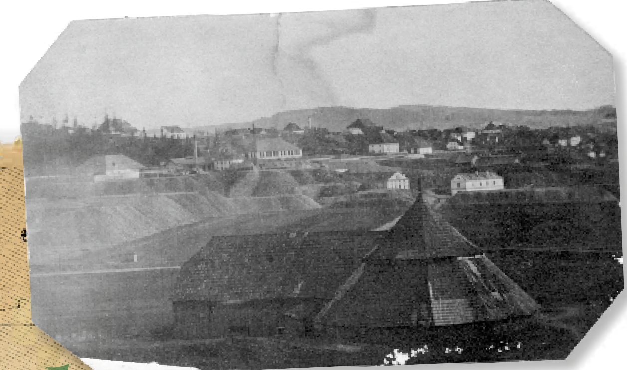
Důl Ferdinand, zaražený v r. 1820, na snímku z r. 1863. Zentour byl odstraněn v r. 1866 a následně nahrazen zděnou sachetní budovou. The Ferdinand mine, dug in 1820, in the picture of 1863. The Driving wheel was removed in 1866 and consequently was replaced by the brick head house.
